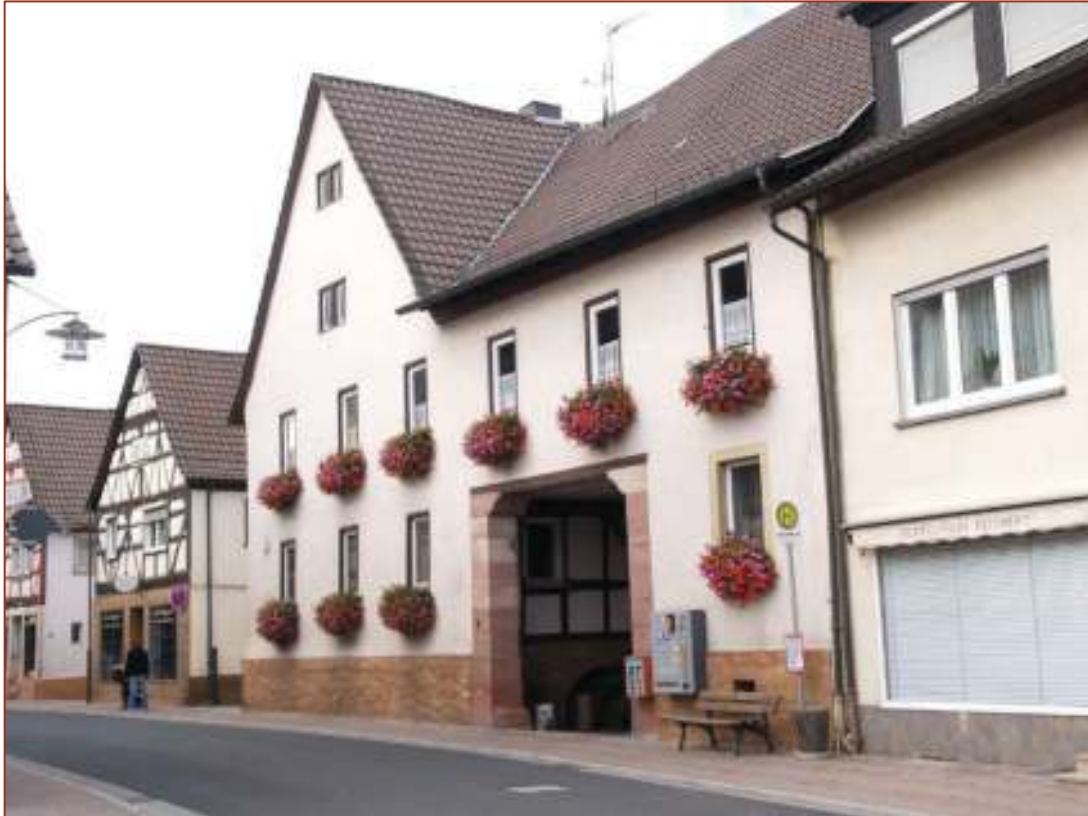
Ehemaliges Gasthaus "Krone" ("Brauerei Volland"), spätes 18./frühes 19. Jahrhundert. Zweigeschossige, verputzte Bauten mit Satteldächern. Hauptgebäude giebelständig, seitliches Tordurchfahrtsgebäude traufständig. Äußeres Erscheinungsbild einheitlich aus dem 19. Jahrhundert.
