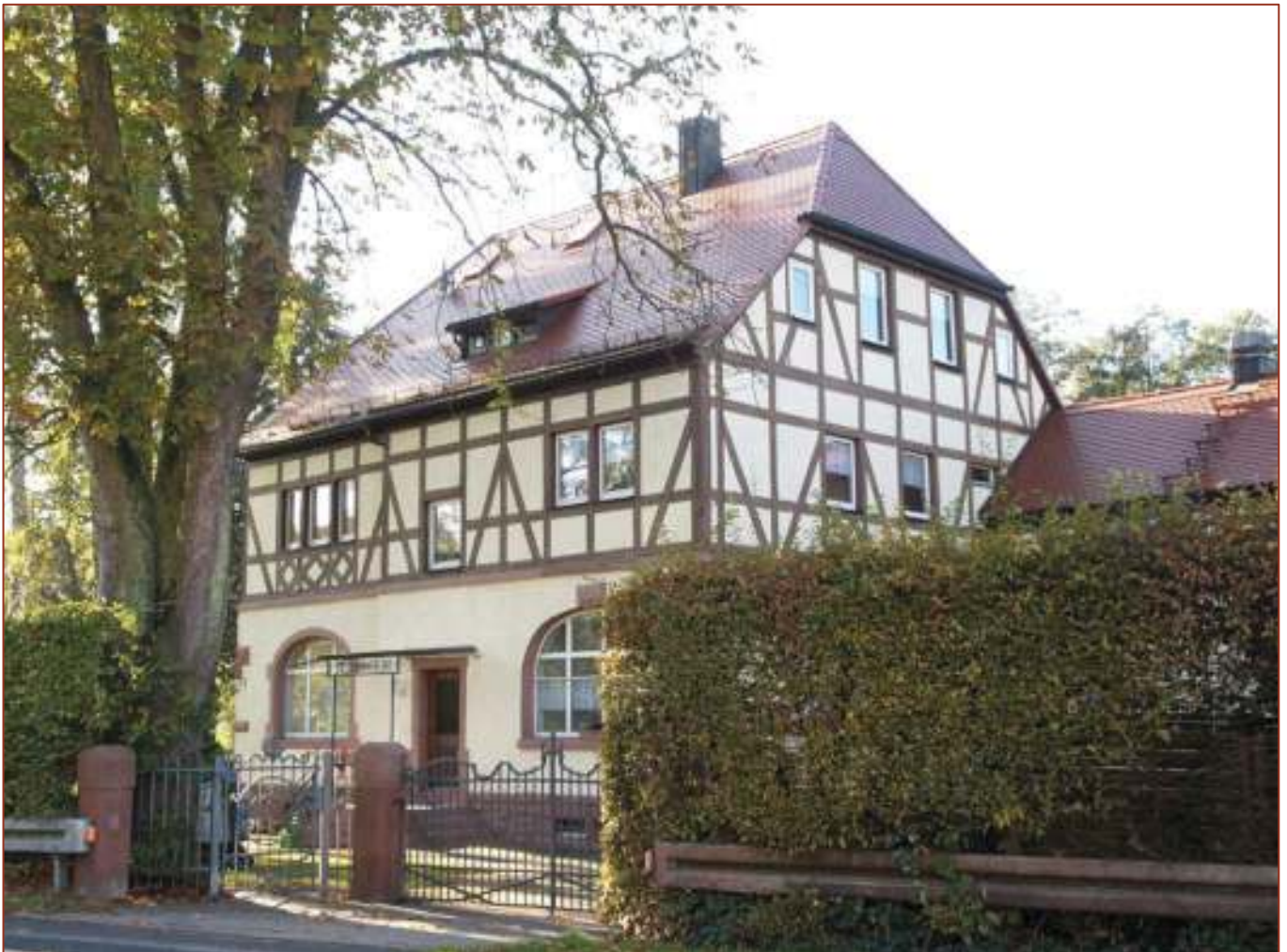
So genanntes "Mütterheim", ehemalige Gastwirtschaft "Zum Spessart", 1910. Stattlicher zweigeschossiger Bau mit Krüppelwalmdach im Heimatstil. Erdgeschoss massiv gemauert und verputzt mit breiten Korbogfenstern, Obergeschoss in historisierendem Sichtfachwerk. 1910 von Carl Volland beim Bahnhof Eschau/Mönchberg errichtet und bis ca. 1943 als Gastwirtschaft betrieben, von 1951 bis 1962 Erholungsheim des Müttergenesungswerkes.
