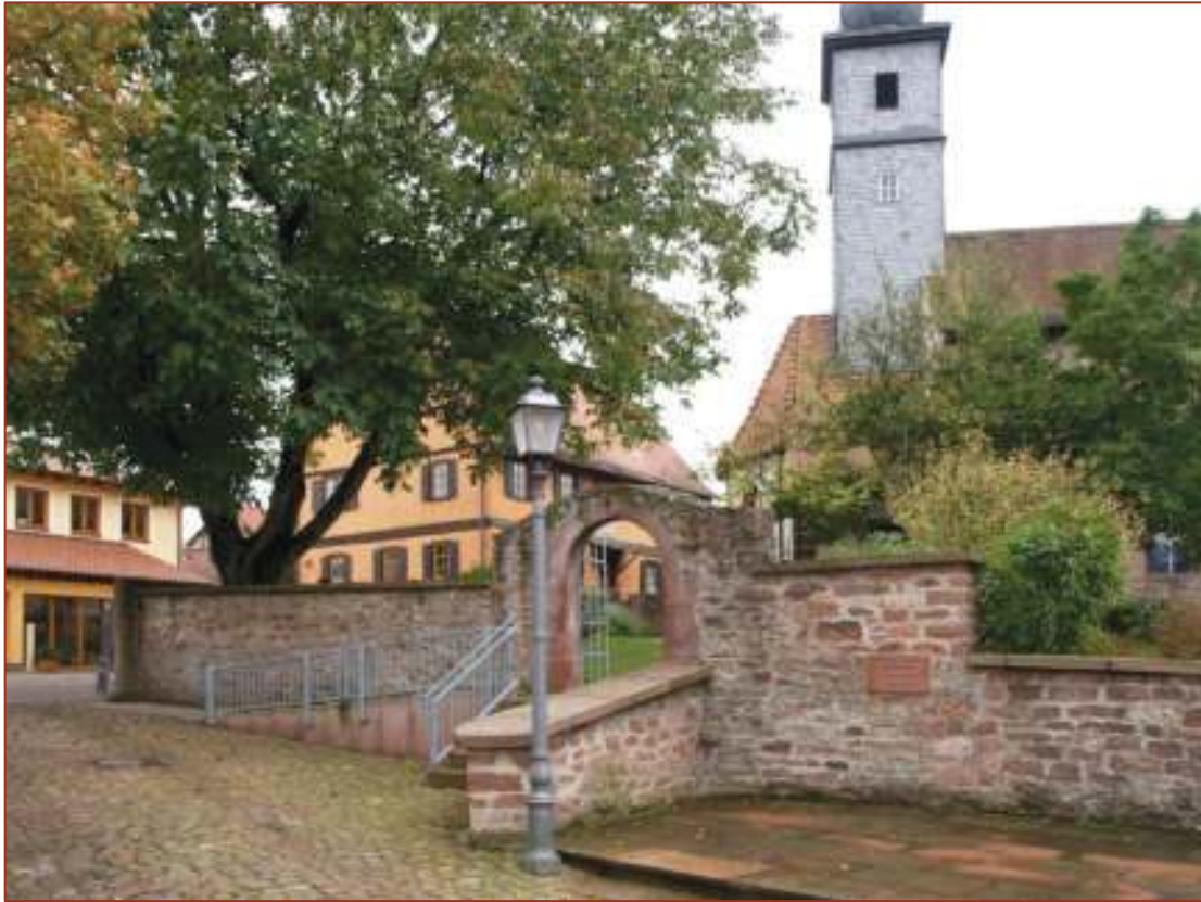
Evang.-Luth. Pfarrkirche, Friedhofsmauer, wohl 15. Jahrhundert. Reste der Ummauerung des ehemaligen Kirchhofes mit dem historischen Eingangsportal zum Kirchhof. Foto 2009
