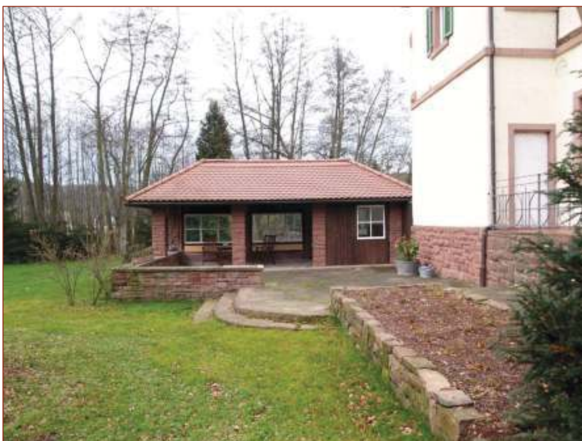
Im zugehörigen parkähnlichen Garten blieb die Kegelhalle der ehemaligen Kegelbahn wohl aus den 1930er Jahren erhalten. Sie wurde zu Zeiten des "Mütterheims" zur Liegehalle umfunktioniert.
