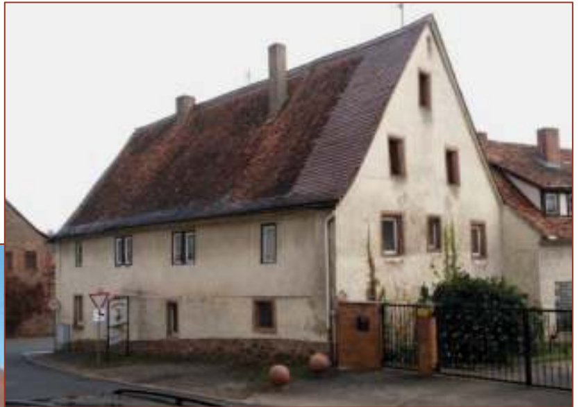
„Hofhaus“ – Wohngebäude. Ansicht vom Gasthaus „Löwen“. Foto DEB 2009
