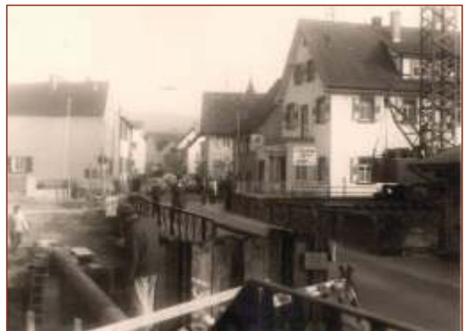
Ein Blick von Sommerau nach Eschau um 1969. Vorbereitende Arbeiten für den Brücken-Neubau.
