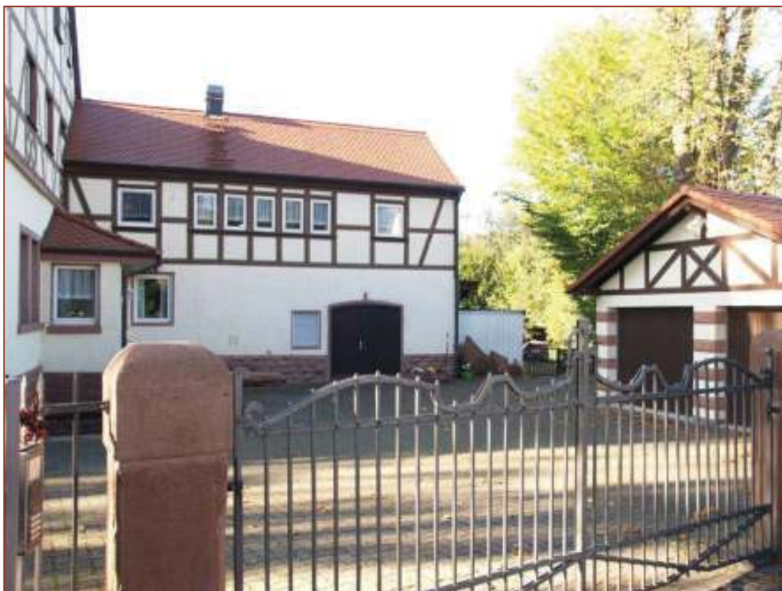
Bauzeitlich errichtetes Nebengebäude im nördlichen Anschluss an den Hauptbau.
