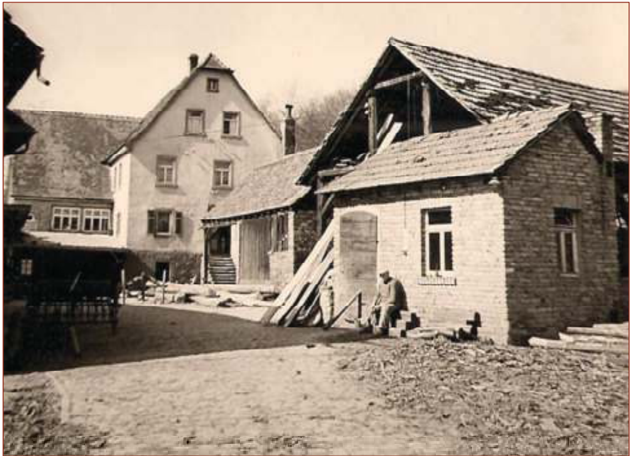
Die „Geißheckenmühle“, eigentlich – Neumühle -, Getreide- und Schneidmühle. Foto um 1950. Gründung 1862/63
