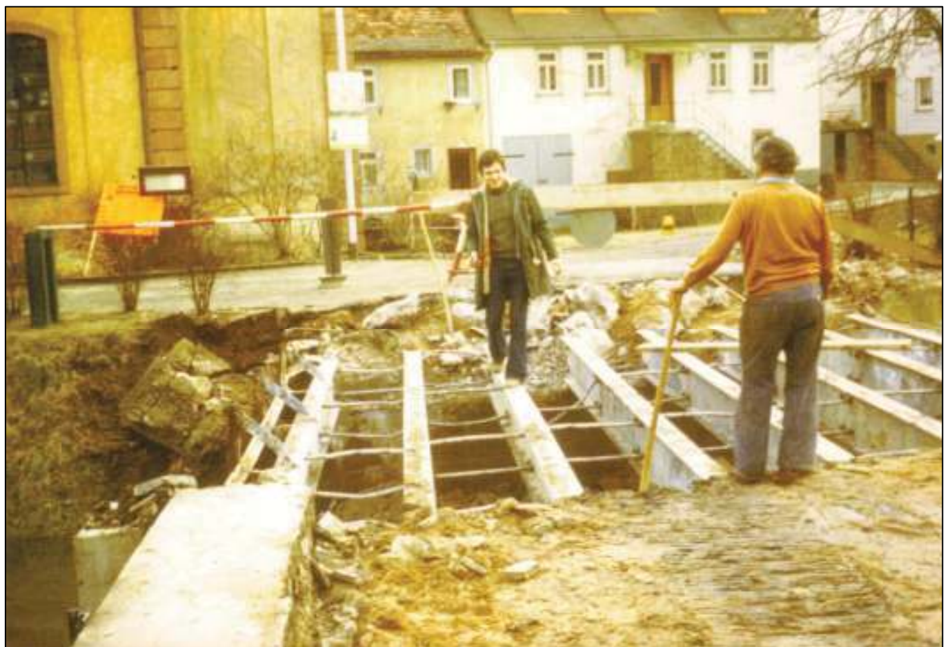
Die alte Elsavabrücke hat ausgedient und wird abgerissen. Foto um 1966.
