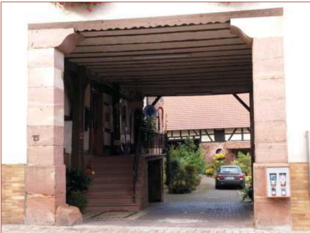
Ehemaliges Gasthaus "Krone" ("Brauerei Volland"), spätes 18./frühes 19. Jahrhundert. Blick durch die Tordurchfahrt in den Hof. Seitliche Pilaster in Rotsandstein. Zugehörige Nebengebäude ebenfalls erhalten.
