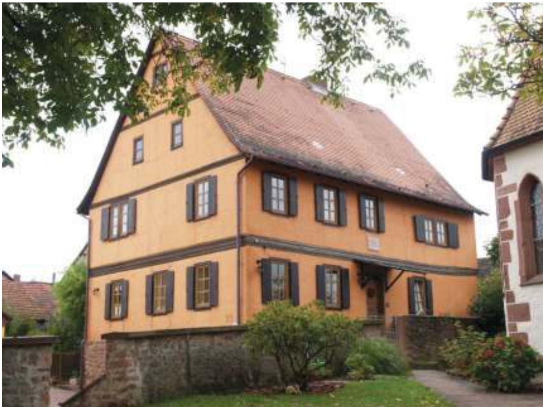
Pfarrhaus, 17./18. Jahrhundert. Zweigeschossiger, verputzter Fachwerkbau mit Satteldach über hohem, natursteinsichtigem Kellergeschoss. Mit ummauertem Pfarrgarten. Die dazugehörige Pfarrscheune 1967/68 für den Bau eines Jugendheimes abgebrochen. Foto 2009
