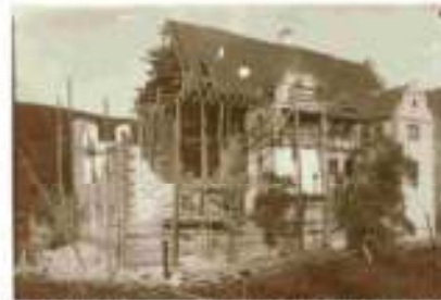
Das Schloss Oberaulenbach wurde 1912 grundlegend saniert und dabei instandgesetzt.
