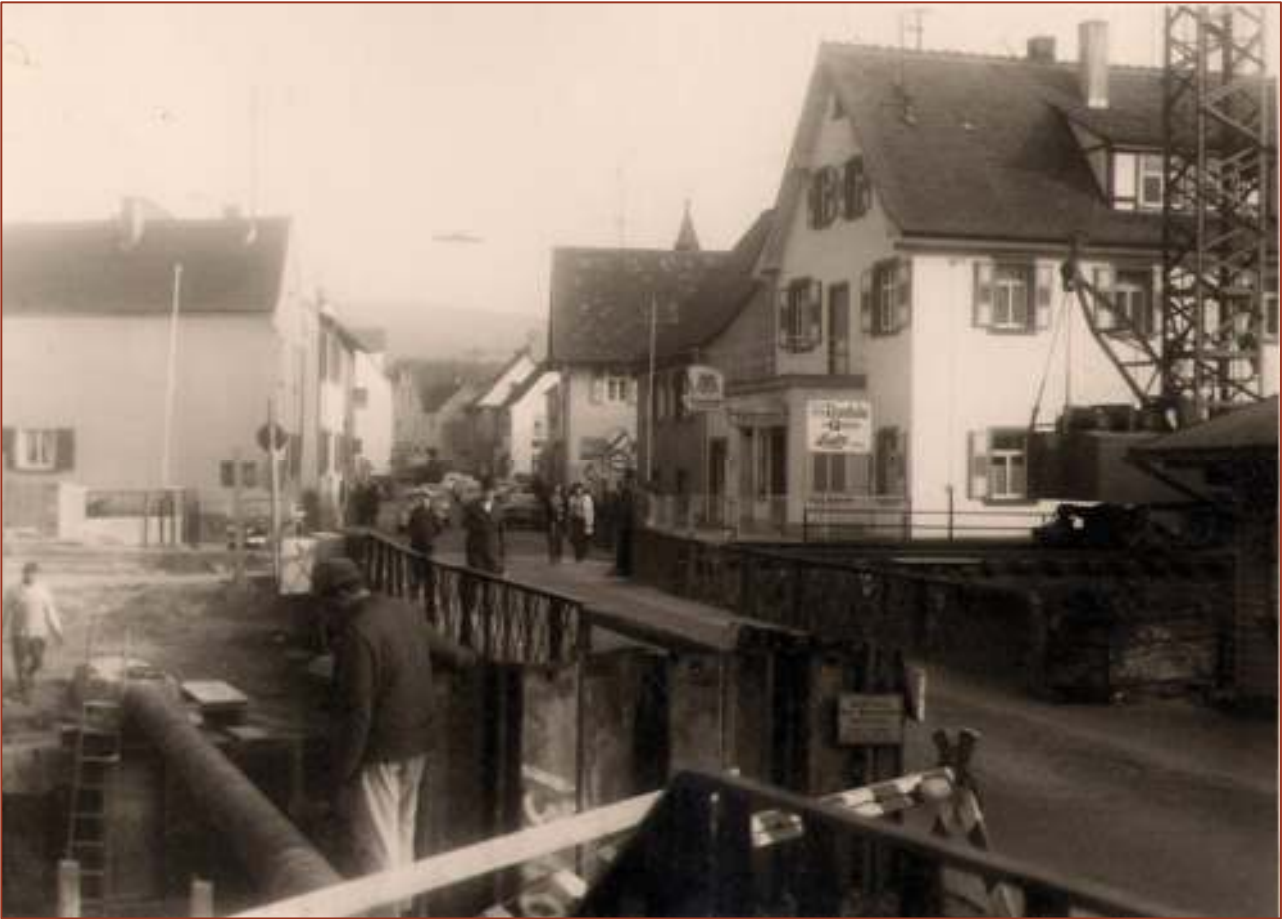
Der Bau der neuen Elsavabrücke, um 1970, ist in vollem Gange
