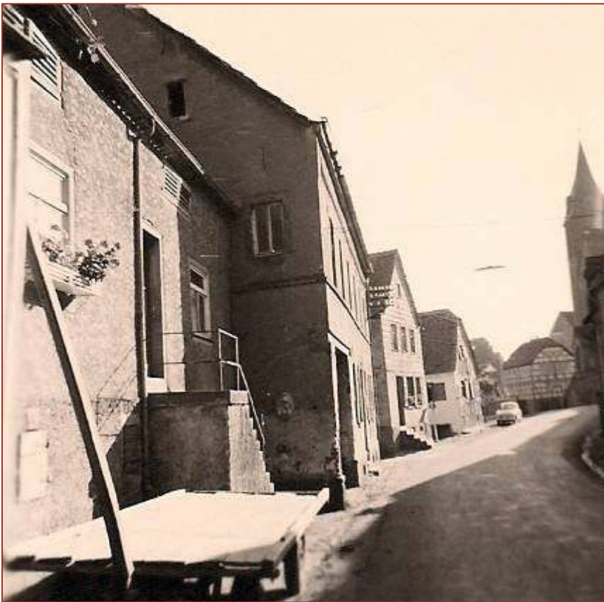
Links die HsNr. 142 („Krone“-Anbau), vorspringend an der Straße die HsNr. 140 („Krone“)
