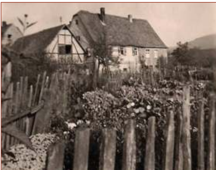
Foto: Aus dieser Sicht die linke Hälfte des Doppelhauses, rechte Haushälfte Bäckerei Englert
