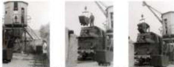
Bis zum Schluss im Jahre 1966 fuhren Dampflokomotiven auf der Trasse Oberburg-Heimbuchenthal. Dort an Endbahnhof gab es einen Krane, mit dem das Befüllen des Tenders mit Kohle möglich war - ein Vorgang, der einen gewissen Aufwand erforderte.
