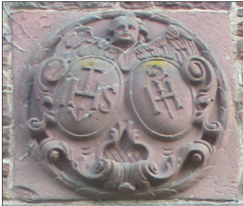
Kloster Himmelthal – Wappenstein über der Toreinfahrt.
