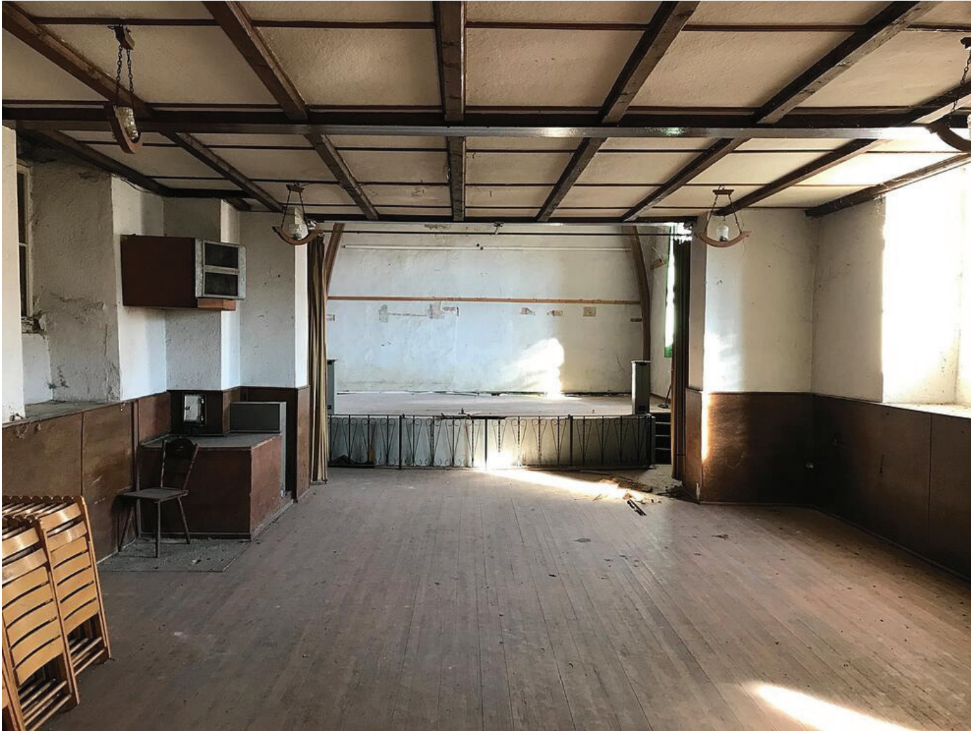
Blick vom Haupteingang über den Saal zur Bühne. Die Zwischendecke wurde 1957/58 eingezogen.
