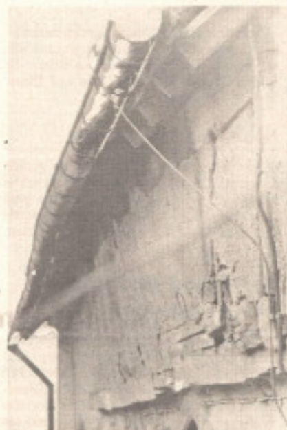
SCHWERE SCHÄDEN , wo man hinschaut. Die Dachrinne ist defekt, das eindringende Wasser hat die Mauer herausgedrückt (links). Wo der Glockenturm auf dem Dach aufsitzt, fehlt ein Teil der Schieferverkleidung. Die Steine sind locker, die Tragebalken vermorscht.
