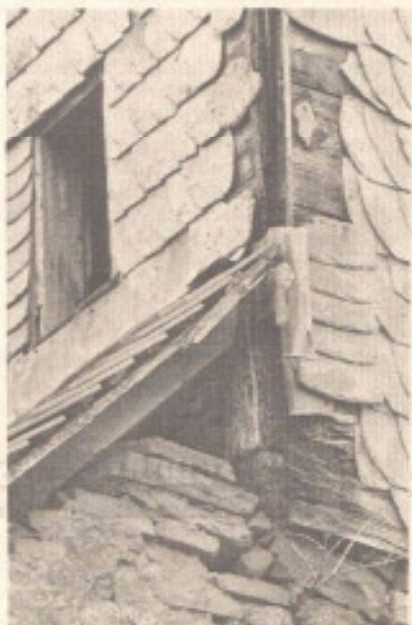
SCHWERE SCHÄDEN , wo man hinschaut. Die Dachrinne ist defekt, das eindringende Wasser hat die Mauer herausgedrückt (links). Wo der Glockenturm auf dem Dach aufsitzt, fehlt ein Teil der Schieferverkleidung. Die Steine sind locker, die Tragebalken vermorscht.
