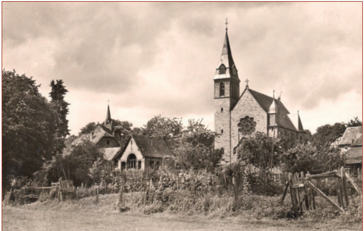
Alte und neue Pfarrkirche „St. Laurentius“.
