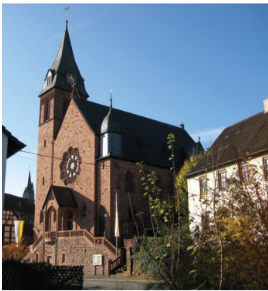
Pfarrkirche „St. Laurentius“ nach der großen Renovierung 2013. - Foto 11/2013.
