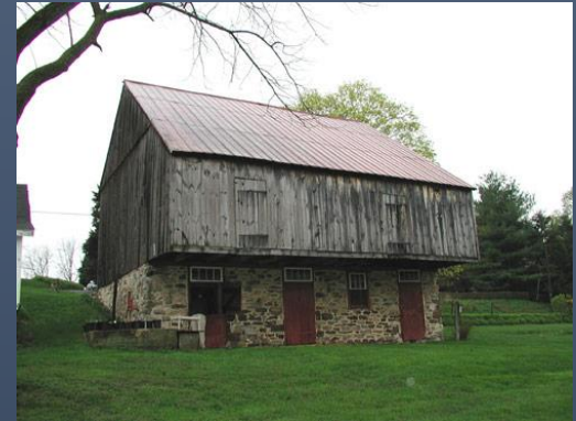
Typische deutsche Scheune in Berks County, Pennsylvania „German Barn“
