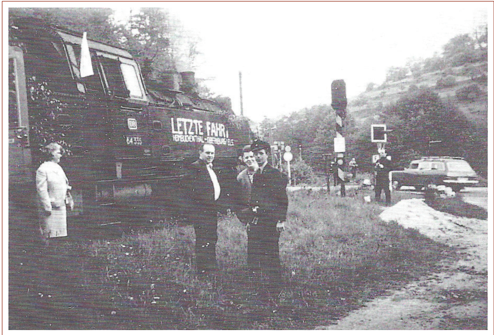
Am Bahnübergang „Wintersbach - Neuhammer“
