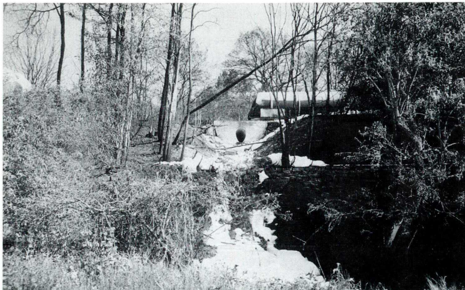
Folgen des Brandes an der angrenzenden Böschung; bei der Brandbekämpfung an den Kesselwagen mußten große Mengen Schaum eingesetzt werden.
